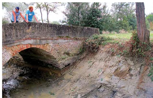
ment complet du ruisseau, il a été procédé à un curage du lit aux abords du barrage et du pont. Les embâcles ont été retirés du ruisseau et les arbres élagués sur les deux rives.
