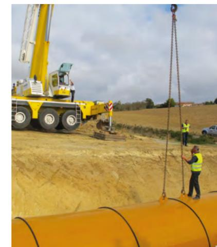
Dans le cadre de la réalisation du lotissement Bellevue, le plan d'aménagement a prévu la mise en place d'une réserve d'eau à vocation de protection contre les incendies. C'est donc une citerne métallique de 120 m<sup>3</sup> qui a été
